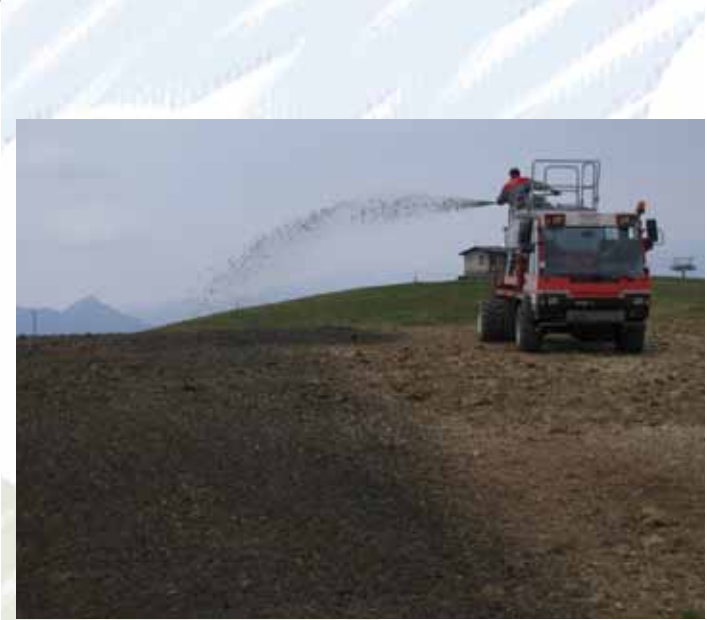
Idrosemina di fiorume su pista da sci del M. Pora (BG) (foto A. Ferrario)
