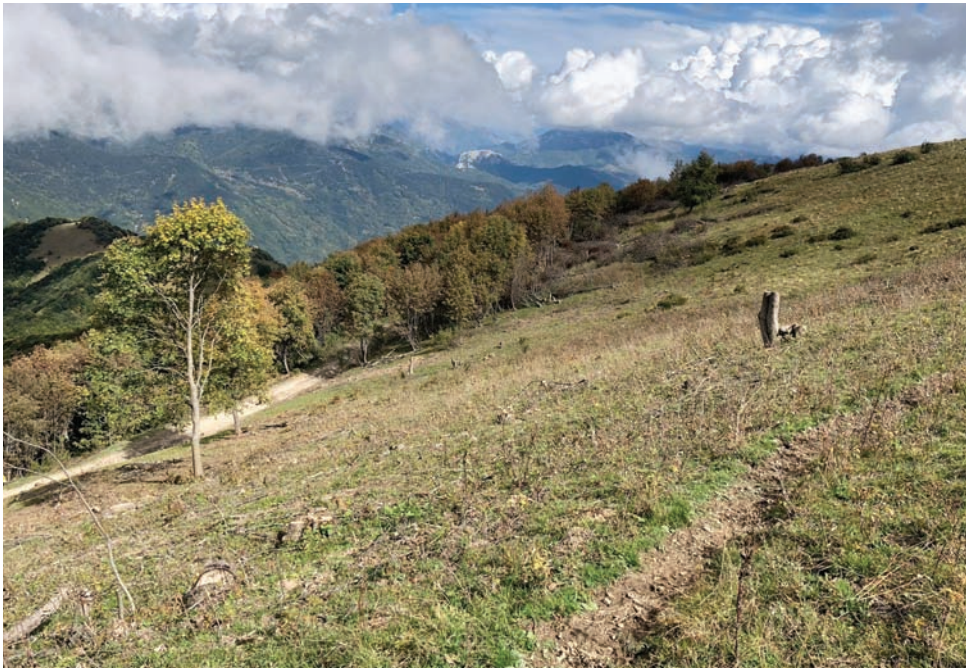
Figura 11. Cantiere presso Poggio Fearza
